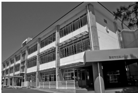
圖 1：靜岡縣葵小學的粗大圓柱的耐震建築
