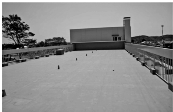
圖 3：日本東松島市浜市小學校供海嘯避難的屋頂
