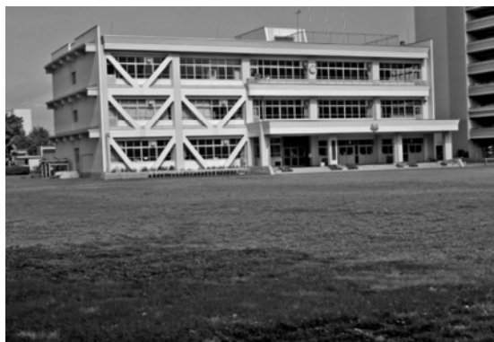
圖 2：青森市橋本小學的耐震建築及細石子透水鋪面操場
